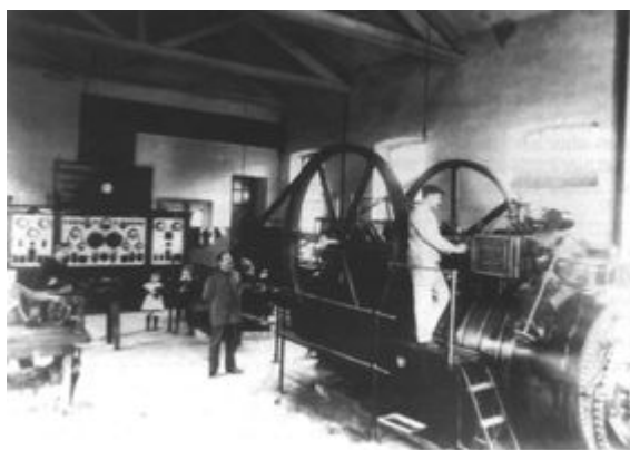
Das Turbinenhaus des Elektrizitätswerks Burgbrohl, um 1898
