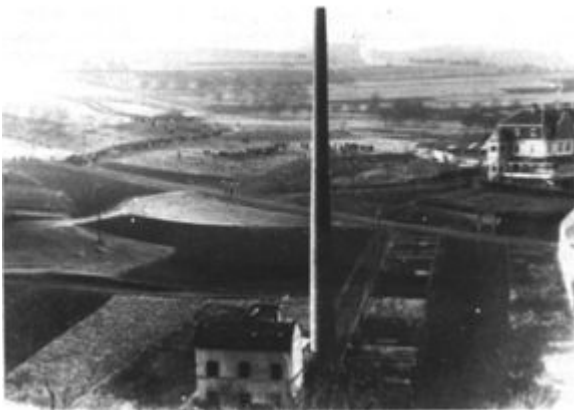
Das Elektrizitätswerk Adenau in den 1920er Jahren.
